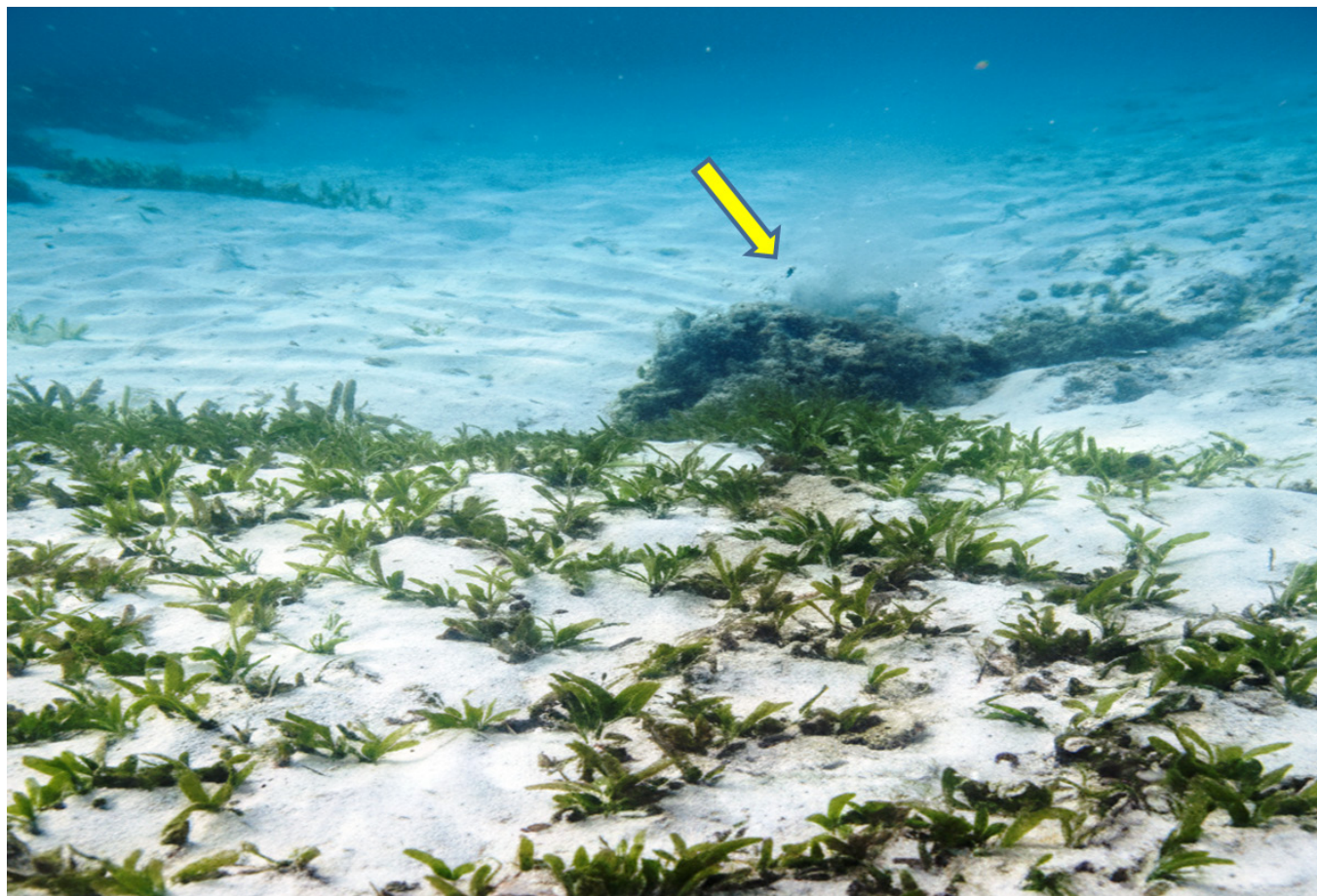
Figura 3.- Fuga de aguas servidas por una válvula dañada de un colector submarino en la bahía de Cata (señalada con una flecha en la imagen), en las proximidades se observa la colonización del sustrato por el pasto marino exótico H. stipulacea (fotografía tomada en diciembre de 2024, cortesía de José Luis Hernández, Pilardive).
