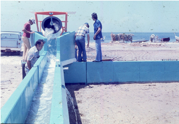
Fig. 1. Llenado inicial de los estanques de la Granja de Cultivos marinos mediante el "tornillo de Arquímedes". En primer plano a la izquierda el Ing. Jaime Aparicio.
